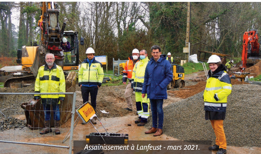
Enfouissement des réseaux dans le centre-ville.
