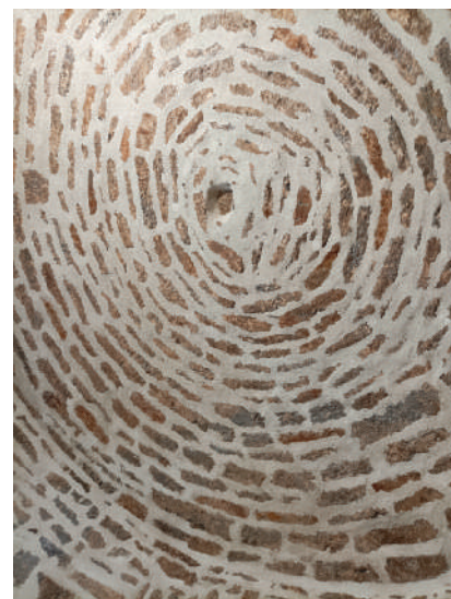
Rénovation de la voûte du rez-de-chaussée du phare
