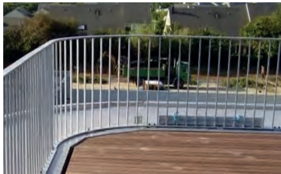
Garde corps en acier inoxydable à barreaudage vertical
