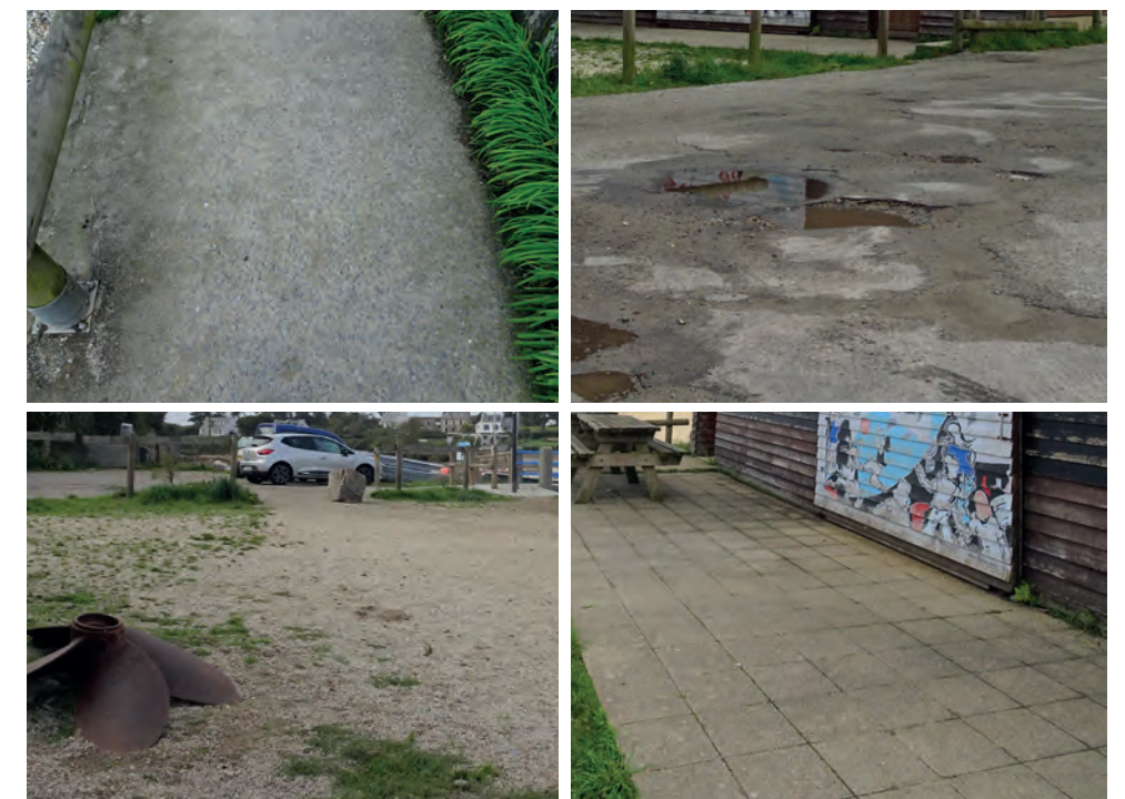
Chemin piéton (GR34) : béton / placette : enrobé / «esplanade» du centre de loisir : gravillons / terrasse : dallage
