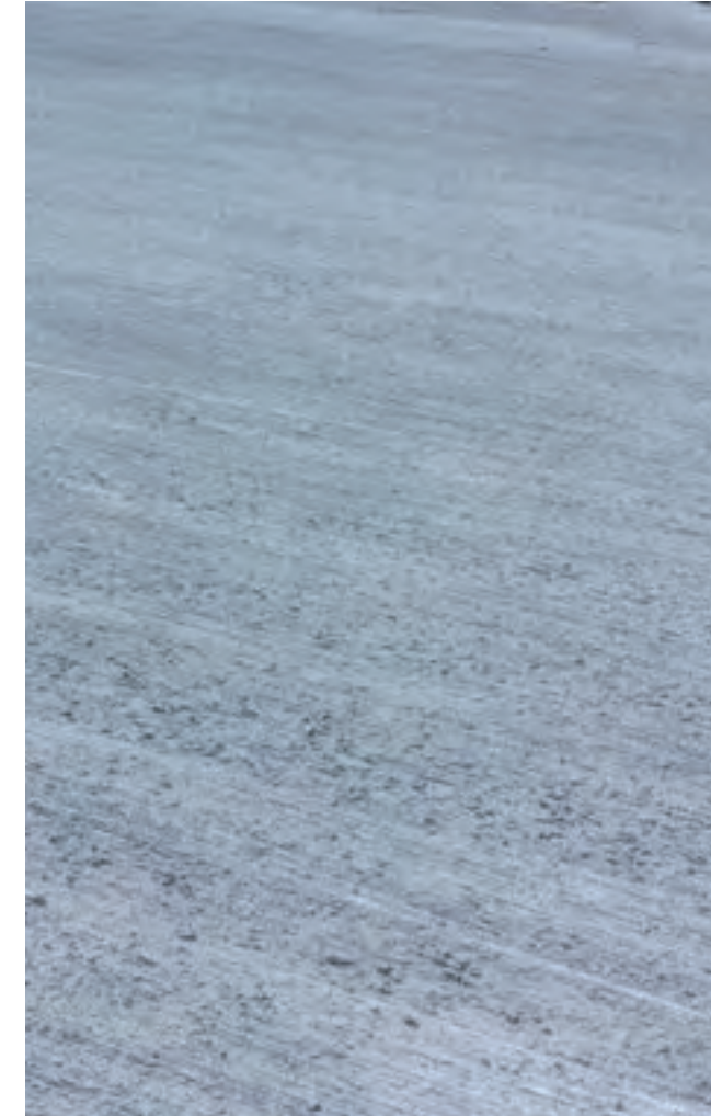
Un changement de revêtement pour marquer le carrefour et faire ralentir : le béton balayé ou désactivé, dans un esprit «cale de mise à l'eau»
