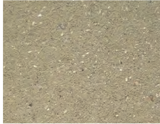
Pour éviter l'érosion liée à la pente, la descente piétons depuis le carrefour réalisée en béton micro désactivé
