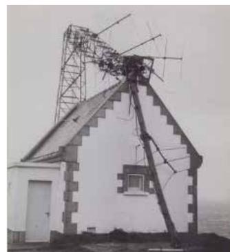
On aperçoit au centre droit de la photo les deux cabanes qui ont abrités les premiers opérateurs radio pendant la construction du centre. A côté, novembre 1965, tempête, rupture du pylône déséquilibré par le mât en bois gorgé d'eau ; peu de dégâts sur les OTC.
