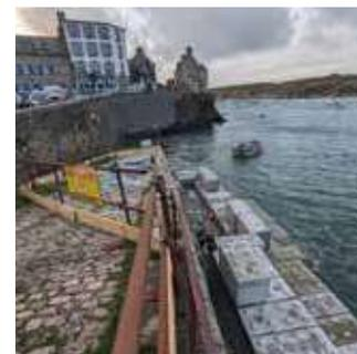
Un système de cubes en béton ressemblant à des LEGO ont été mis en place. Ils ont pour fonction de bloquer les remblais et la destruction du quai.
