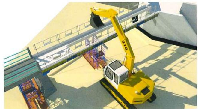
*Après l'installation d'un appui provisoire et la pose des prédalles, Le tablier sera coulé.*
