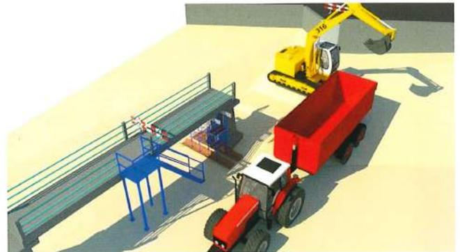
*Après démolition de la culée existante (et évacuation des gravats vers une filière agréée), ainsi que du mur maçonné et dépose des enrochements, l'emprise de la culée et de l'escalier à créer sera terrassée.*
