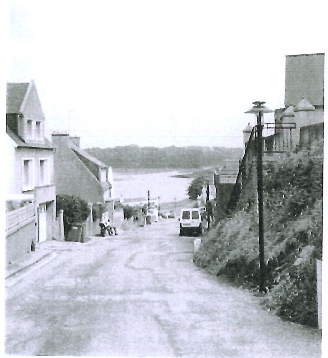
La rue Guépratte après travaux
