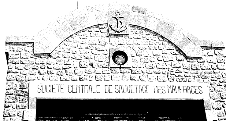
Couronnement en pierres de taille, façonnées dans le kersanton gris, du fronton du second abri pour le canot de sauvetage.
