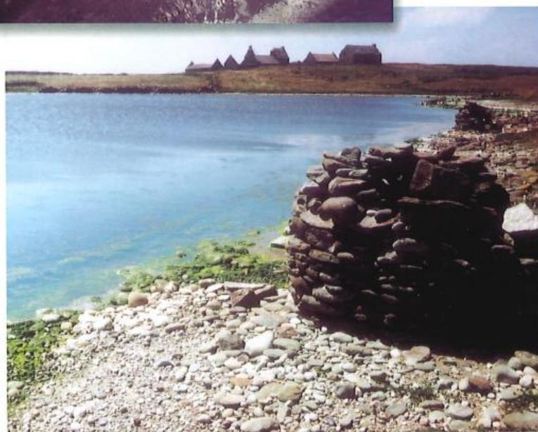
(2) *Gabion construit en pierre sèche (galets de provenance toute proximale) par les chasseurs en bordure du loc'h de Triélen.*
