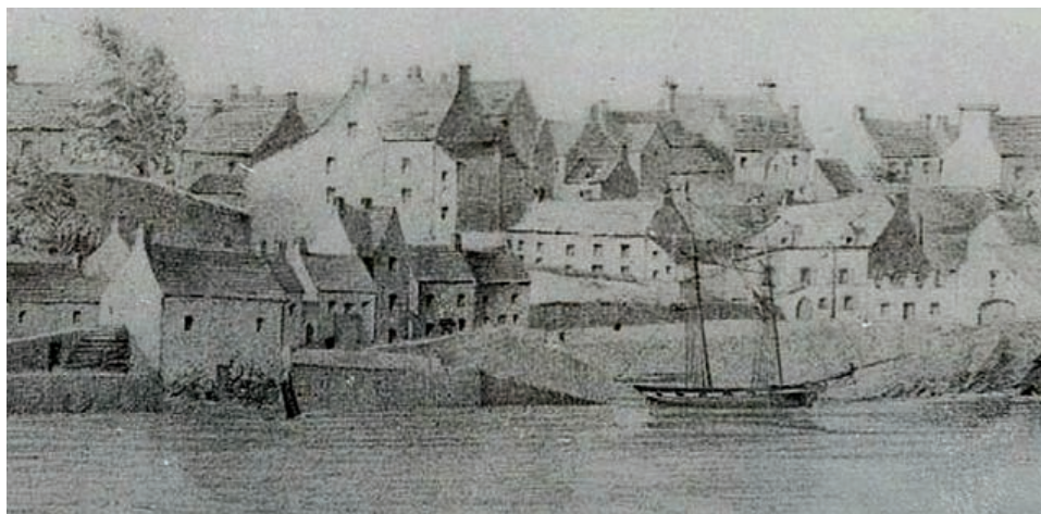
Dessin d'Ernest Le Guerrannic, (détail). Le quai est presque terminé, il reste à détruire le magasin « Bourc'his » au premier plan à gauche qui cache la maison de Lombard.
