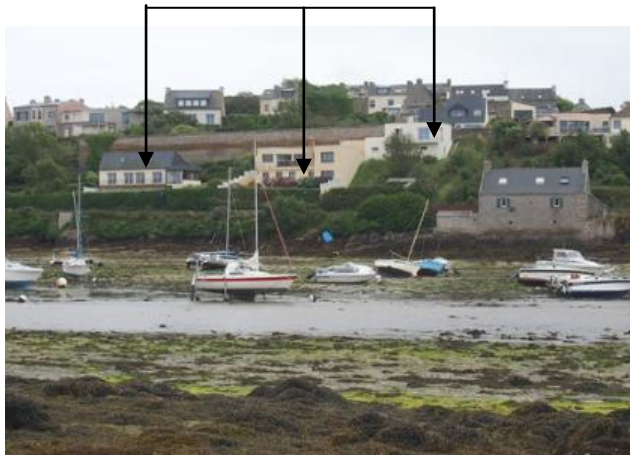
Bâtiments sans enjeu patrimonial
