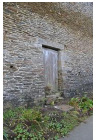
Mur des parcelles 347 -348 - 349
