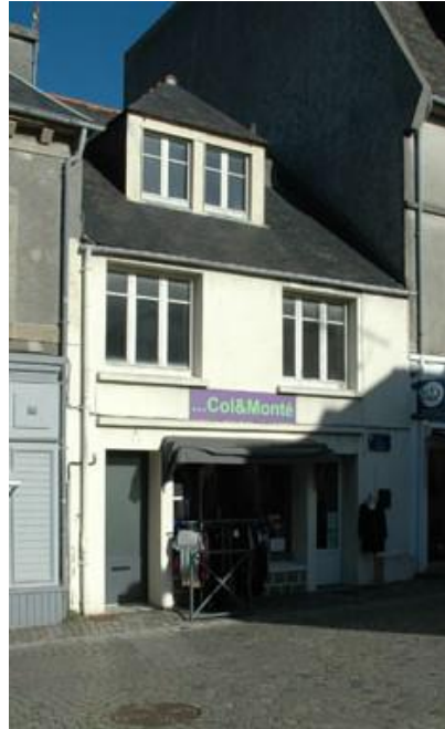
n°4 Bâtiment en rupture avec son environnement
