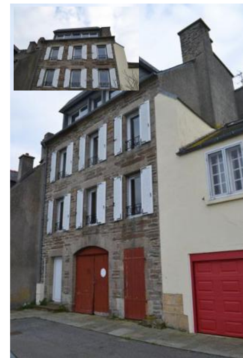
n° 19 Bâtiment d'accompagnement
