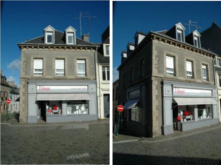
n°2 Bâtiment d'accompagnement
