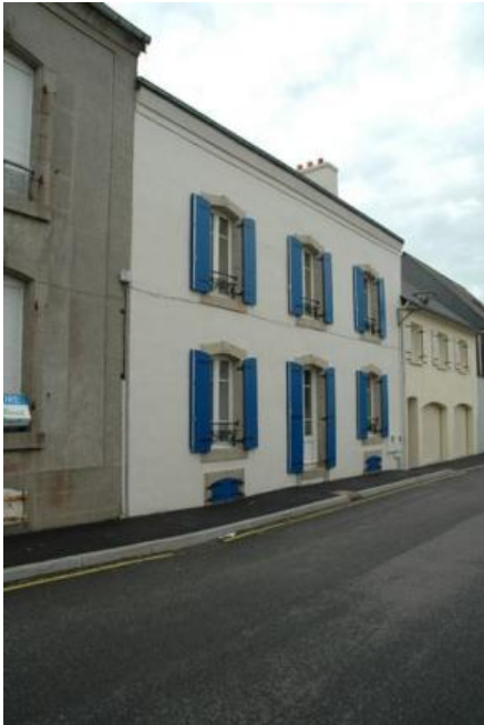
n°8 Bâtiment d'accompagnement
