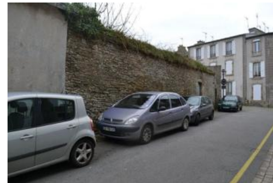
Mur de clôture à conserver
