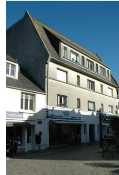
n°6 Bâtiment en rupture avec son environnement
