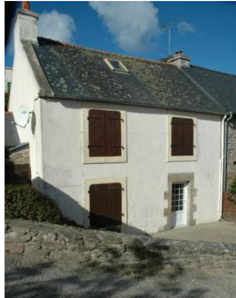
Parcelle 54 Bâtiment d'accompagnement
