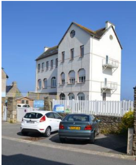
n° 11 Bâtiment en rupture avec son environnement
