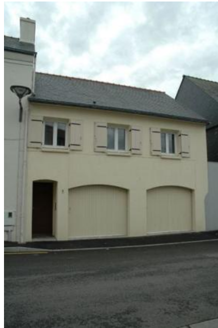
n°8b Bâtiment sans enjeu patrimonial
