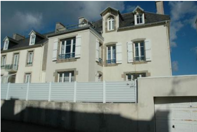
n°6 Bâtiment d'accompagnement
