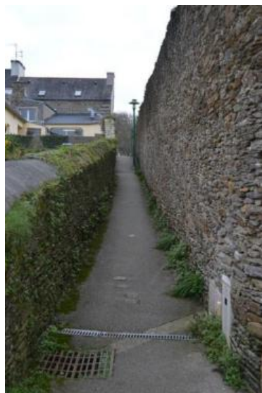
Mur Est et Ouest de la venelle le long des parcelles 877 et 321
