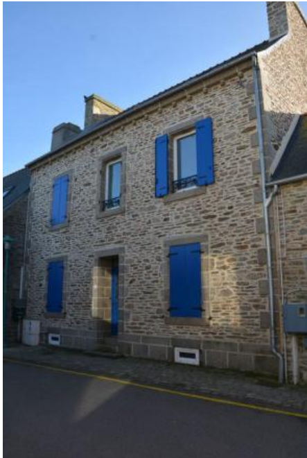
n° 8 Bâtiment d'accompagnement
