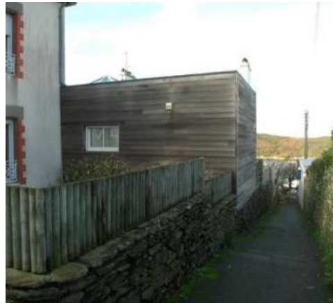
Parcelle n°126 Bâtiment en rupture avec son environnement
