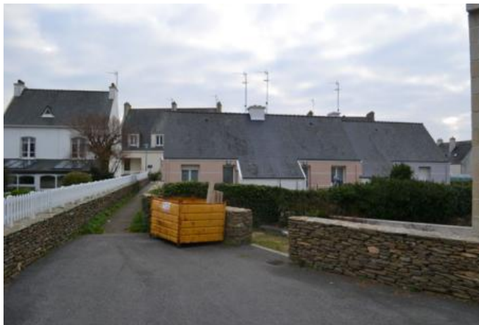
Arrière des maisons du n°17 rue A. Lucas
