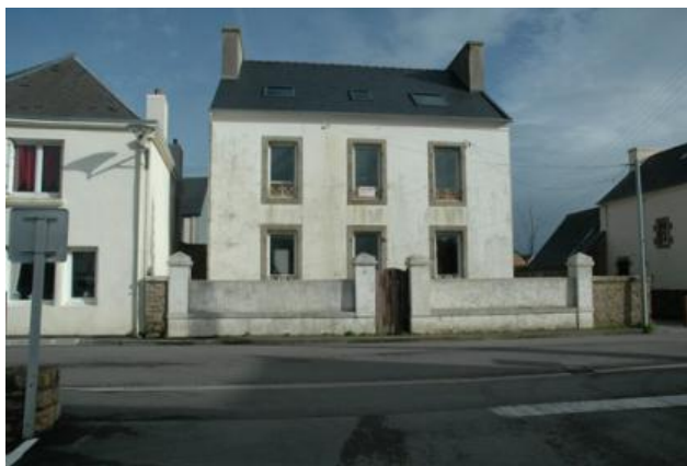
n°4 Bâtiment d'accompagnement
