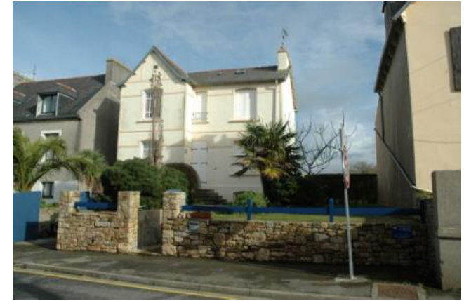
n°24 Bâtiment d'accompagnement
