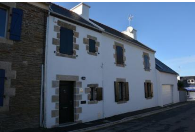
n°26 Bâtiment d'accompagnement
