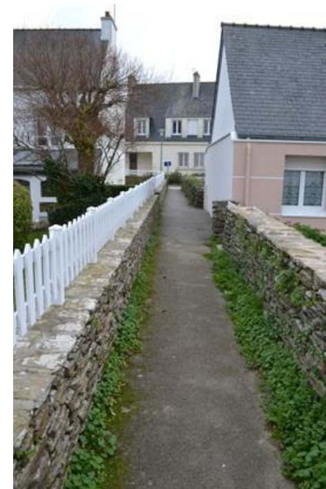
Muret avec clôture PVC du n°15 A. Lucas (voir commentaire)
