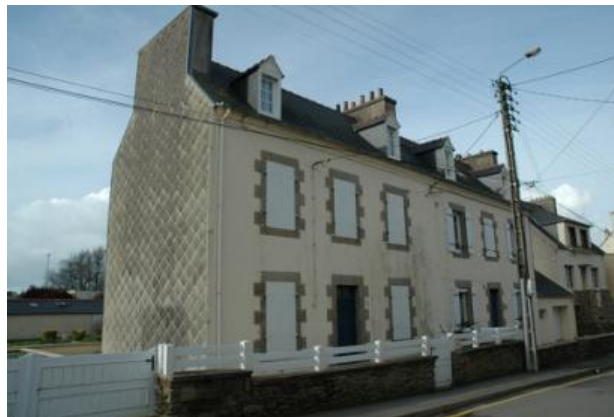
n°33 Bâtiment d'accompagnement
