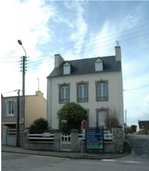
n°25 Bâtiment d'accompagnement
