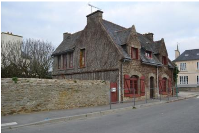
n°1 Bâtiment d'accompagnement
