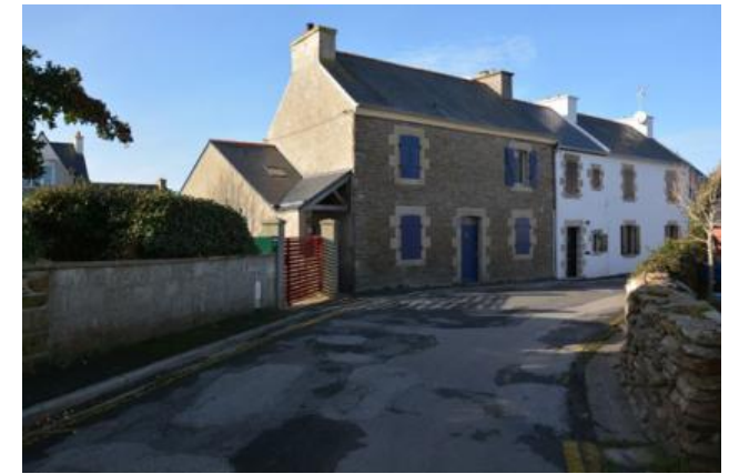
n°24 Bâtiment d'accompagnement
