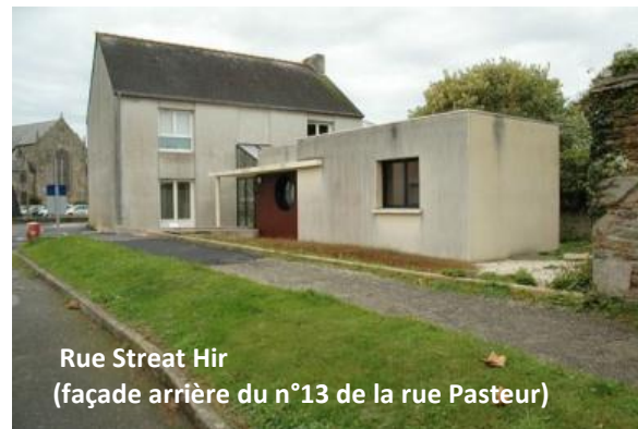
n° 13 Bâtiment en rupture avec son environnement
