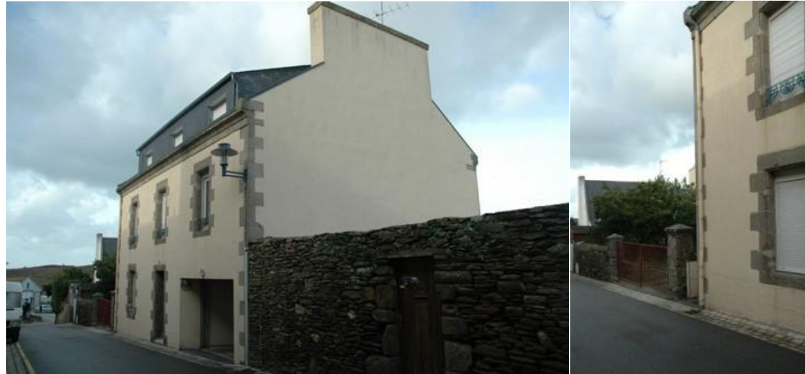
n°9b Bâtiment d'accompagnement
