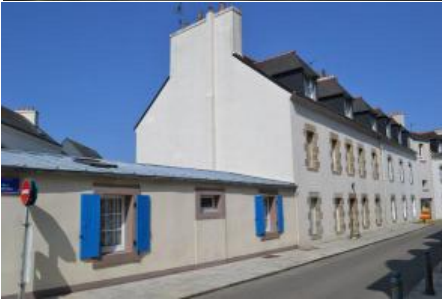
n°31 Façade arrière
