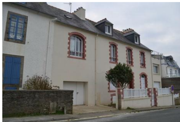
n° 24 Bâtiment accompagnement
