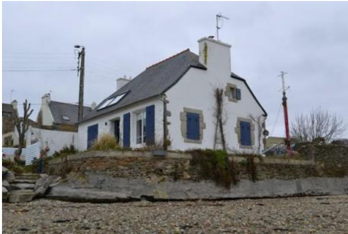
n°2 Chemin de la passerelle Bâtiment d'accompagnement
