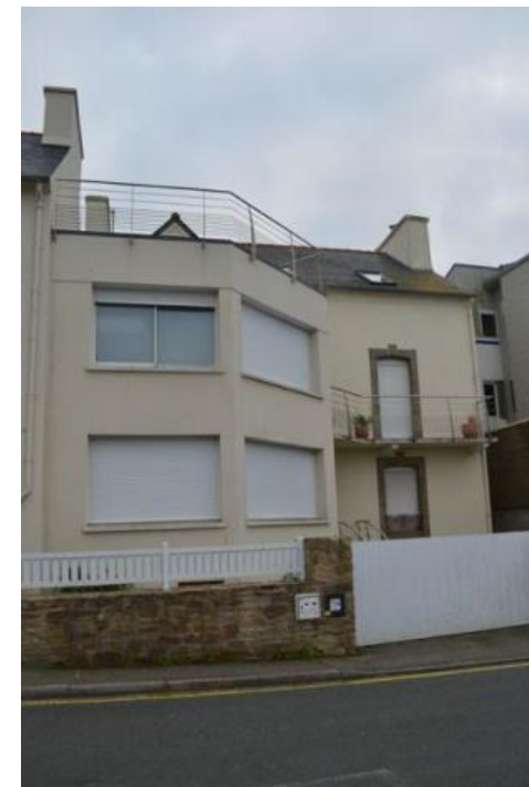
n°26 Bâtiment en rupture avec son environnement
