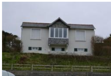
Façades arrières des n°17, 13, 9, 7 et 5 rue Sainte Barbe Bâtiment sans enjeu patrimonial
