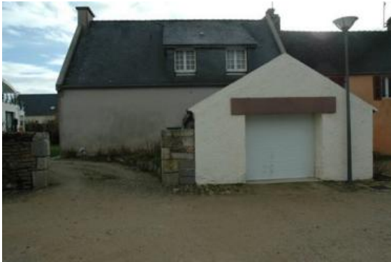
n°6 Bâtiment en rupture avec son environnement
