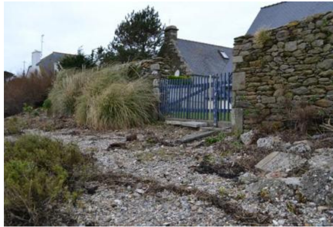
Parcelle n°685 Bâtiment d'accompagnement
