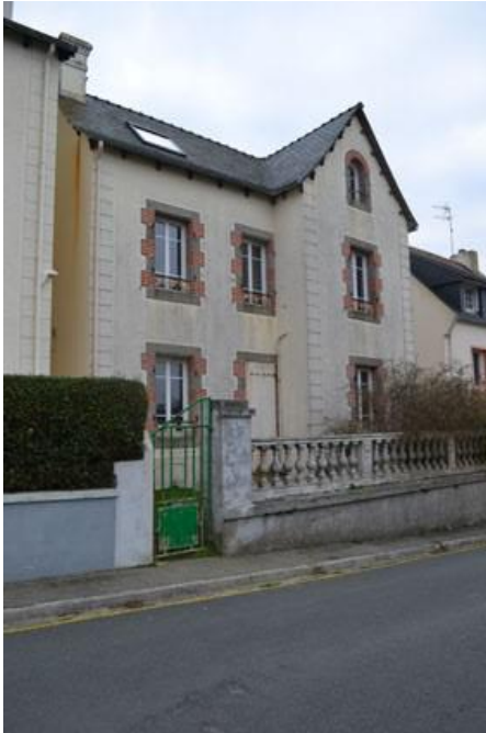
n°14 Bâtiment accompagnement
