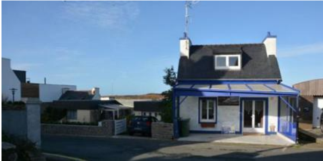
n°9 Bâtiment en rupture avec son environnement
