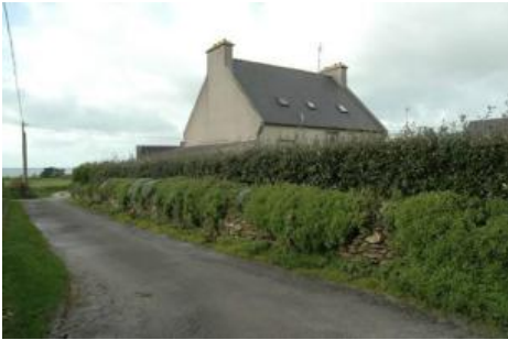
n°4 Bâtiment sans enjeu patrimonial (vers le lavoir)
