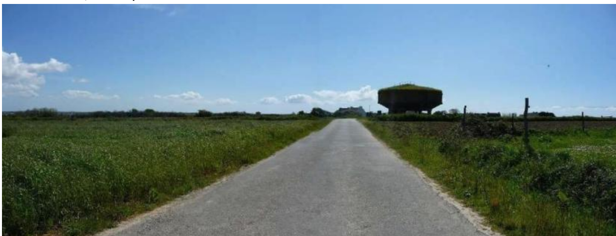
Le château d'eau, situé en point haut de la rue Milin Avel
