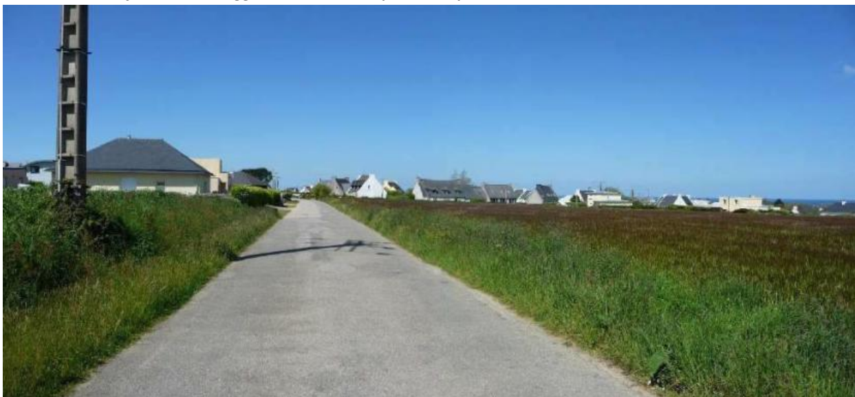
Limite actuelle du front bâti de l'agglomération du Conquet, vu de puis la rue Milin Avel
