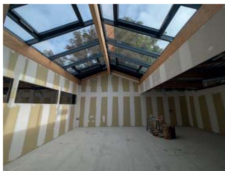
L'une des salles au nord, toute refaite avec une belle verrière dont les volets occultants seront posés incessamment - comme le reste des finitions, imminentes.
