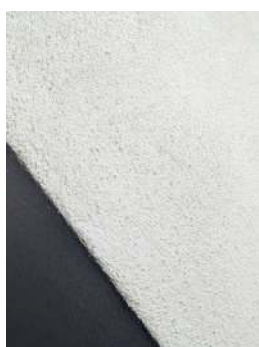
Le mur côté cour, doublé en chaux-chanvre, un matériau biosourcé.
