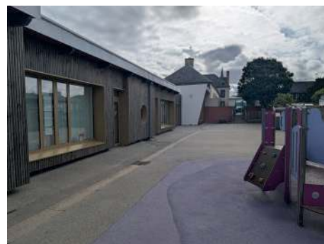
Une vue depuis la cour de l'école maternelle, rénovée lors de la première phase des travaux.
